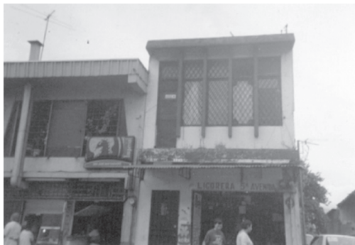
IMAGEN 1 LICORERA EN AVENIDA 5
