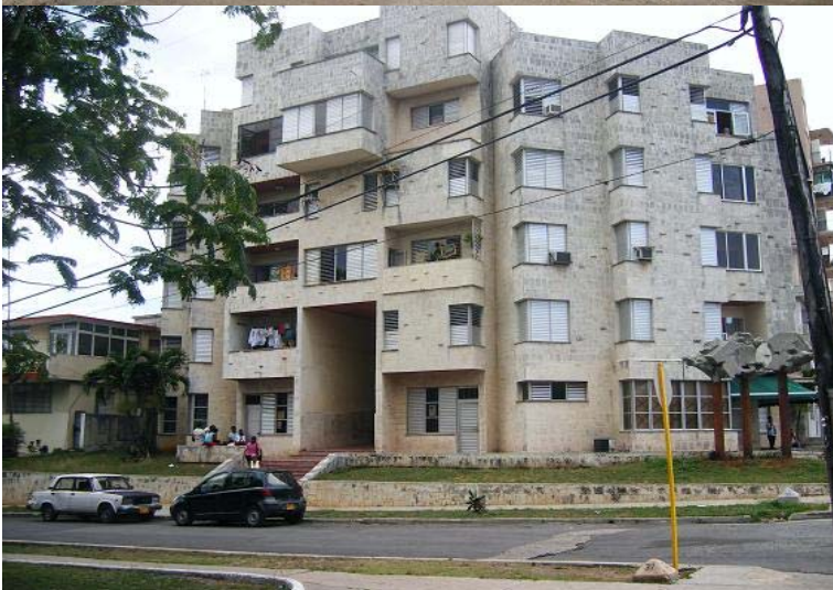
Área trabajada en el barrio de Nuevo Vedado.
