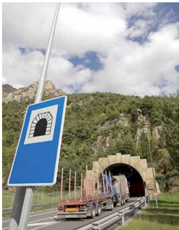
El túnel del Cadí, a la C-16, és una de les infraestructures importants de l'eix E-9 ■ GABRIEL MASSANA / ARXIU
